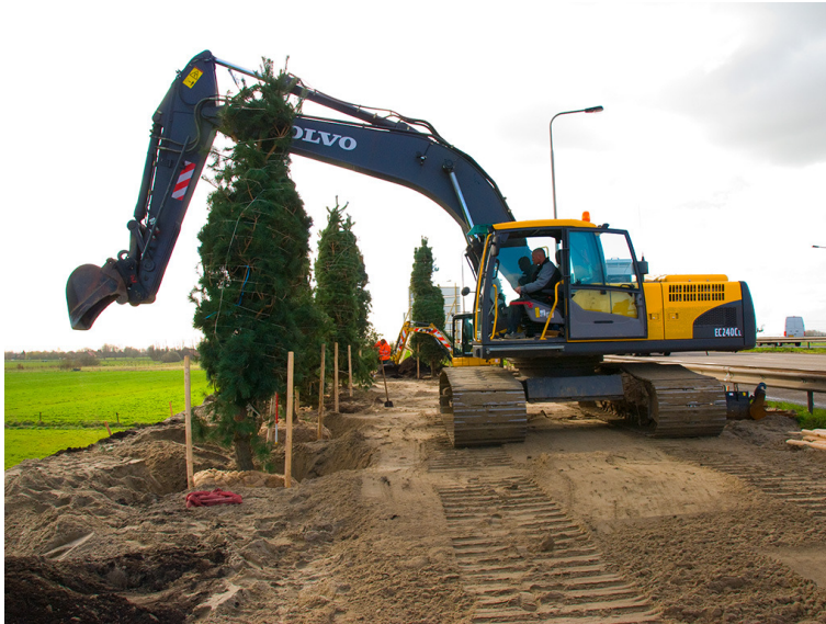
Afbeelding 1.3.4: De naaldbomen worden met kraan in het plantvak geplaatst
