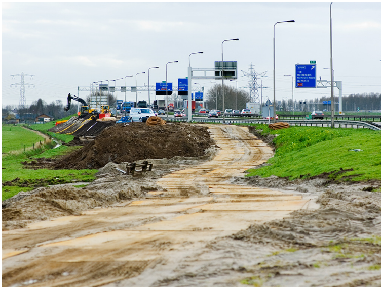
Afbeelding 1.3.3: Rijksweg A50, aanvoer grond voor het grondlichaam
